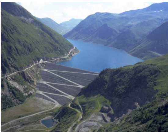
Barrage supérieur de la STEP de Grand'Maison (Isère) EDF © CLAUDE PAUQUET
