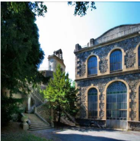
Centrale des Vernes (Isère) EDF © B.MOYEN, P.RISACHER
