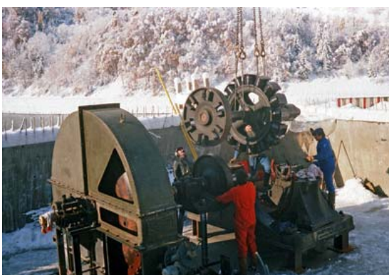
Installation à ciel ouvert du groupe Pelton du Cernon © Droits Réservés
