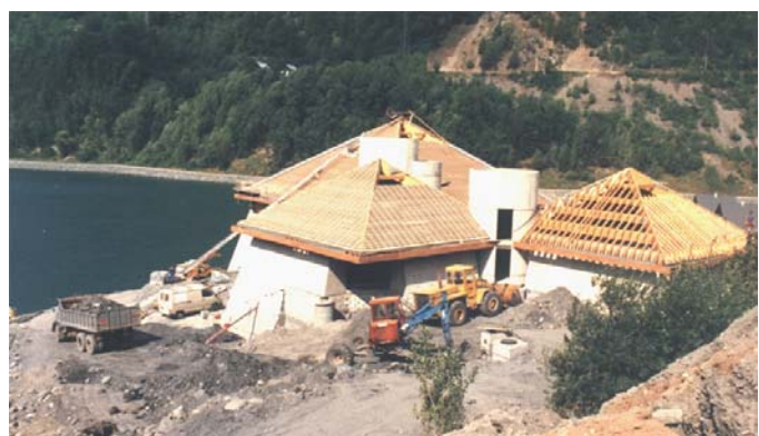
Pose de la couverture © Droits Réservés
